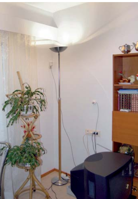
Kuva 36. Valovalpas-järjestelmässä käytetty valaisin. Valaisin sijoitettiin yksion nurkkaan TV:n taakse, jossa se ei häirinnyt muuta sisustusta. Seinällä näkyvät valaisimeen liitetyt anturit.
