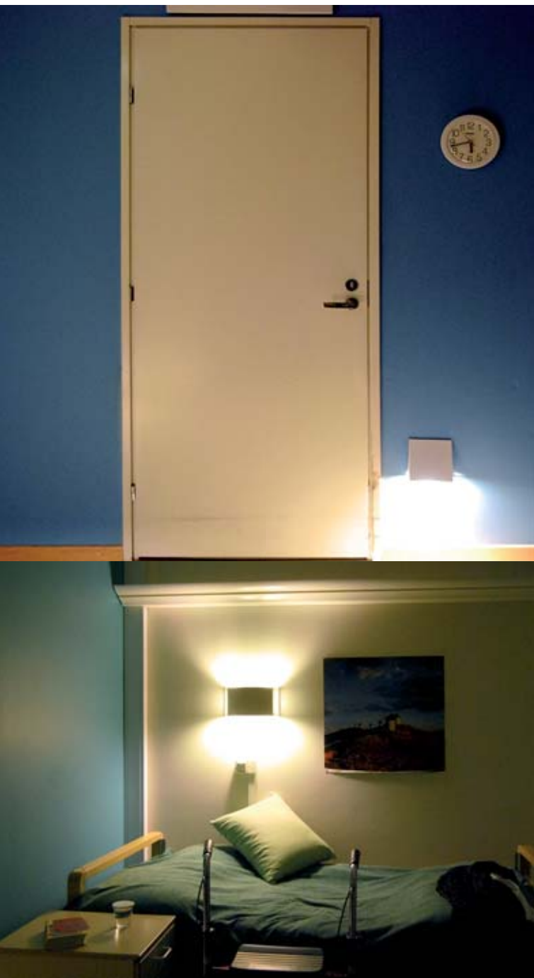
Kuva 30. WC:n ovi erottui seinän maalauksen jälkeen paremmin taustastaan ja myös Wall-yövalo ohjasi WC-tilaan. Sänkyanturi ohjasi lukuvaloa yöaikaan. Lukuvalo syyti himmeänä, kun asukas nousi yöllä vuoteesta.
