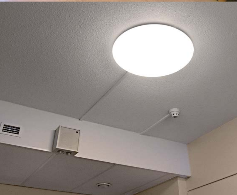
Kuva 26. Poutapilven olohuone ennen remonttia. Olohuone oli valaistu kirkkaalla plafond-valaisimella, joka oli sijoitettu keskelle huoneen kattoon.
