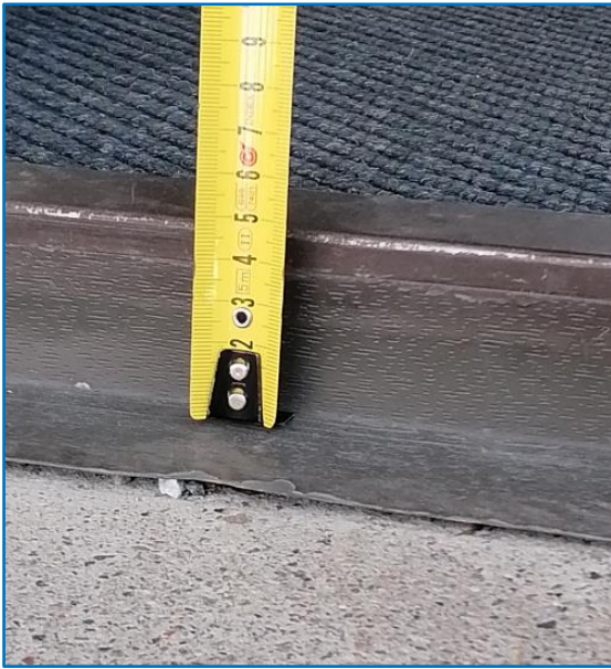
Kuva 8, Ulko-oven kynnys n. 40 mm
