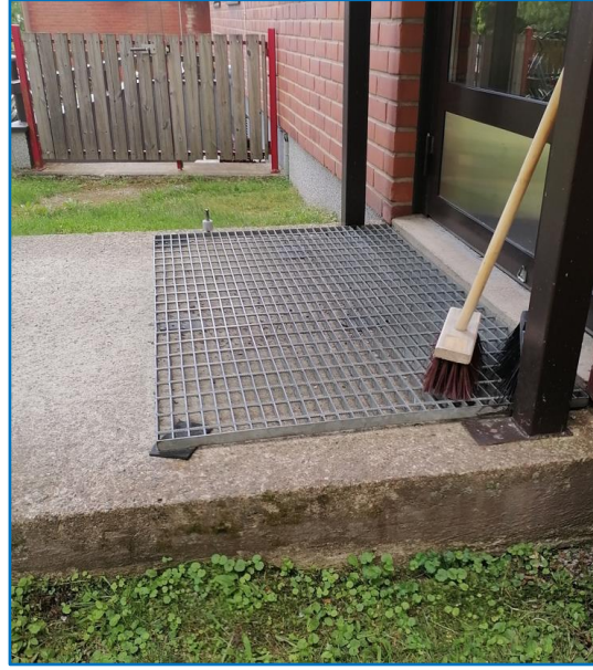
Kuva 9, Poistettavissa olevan ritilän avulla kynnys täyttää asetetun vaatimuksen
