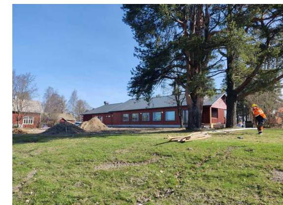
8. Naapuritontille juuri valmistumassa uusi puurakenteinen lastensuojeluyksikkö.
