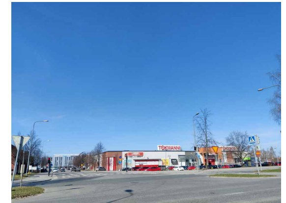
7. Kaupallinen rakennus Pohjolankadun varressa.
