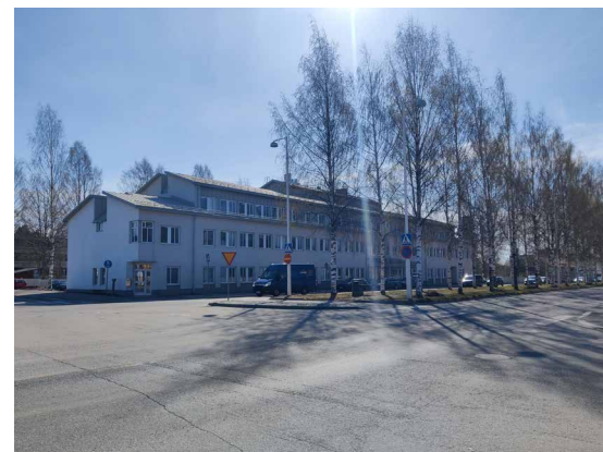
3. Iisalmen kaupungintalo Pohjolankadun varressa.
