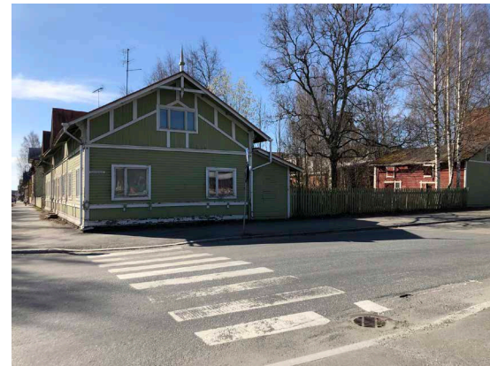
2. Vanha puutalo Pohjolankadun varrelta, joka on menossa purkuun.
