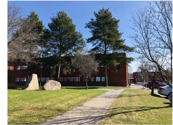
7. Näkymä terveyskeskuksen sisäpihalta kohti veljeskotiä.
