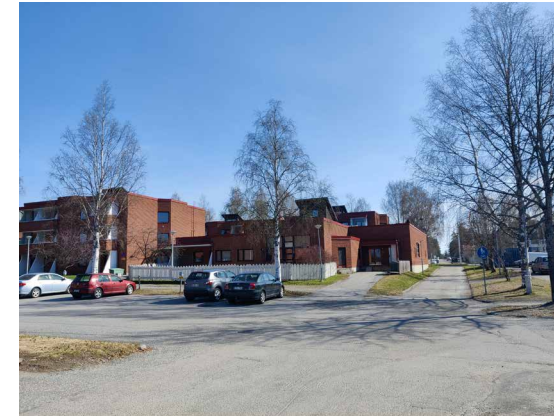
4. Näkymä Louhenkadun ja Louhenpolun risteyksestä.
